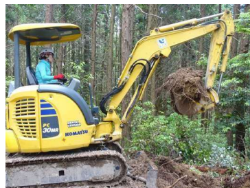
【小型車両系建設機械】
