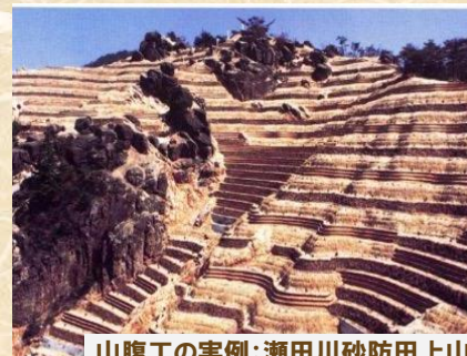
山腹工の実例：瀬田川砂防田上山の山腹工 出典：国土交通省
