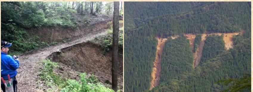
実際に崩壊したところ。その際に盛った土だけではなく、地山も引きづられて崩壊している（右）。
