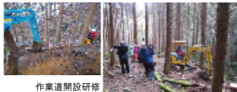
作業道開設研修
